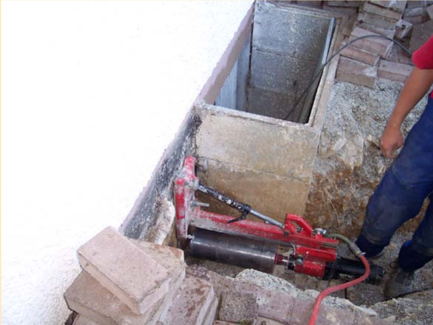
Kernbohrung vom Hausanschlussgraben ins Gebäude
